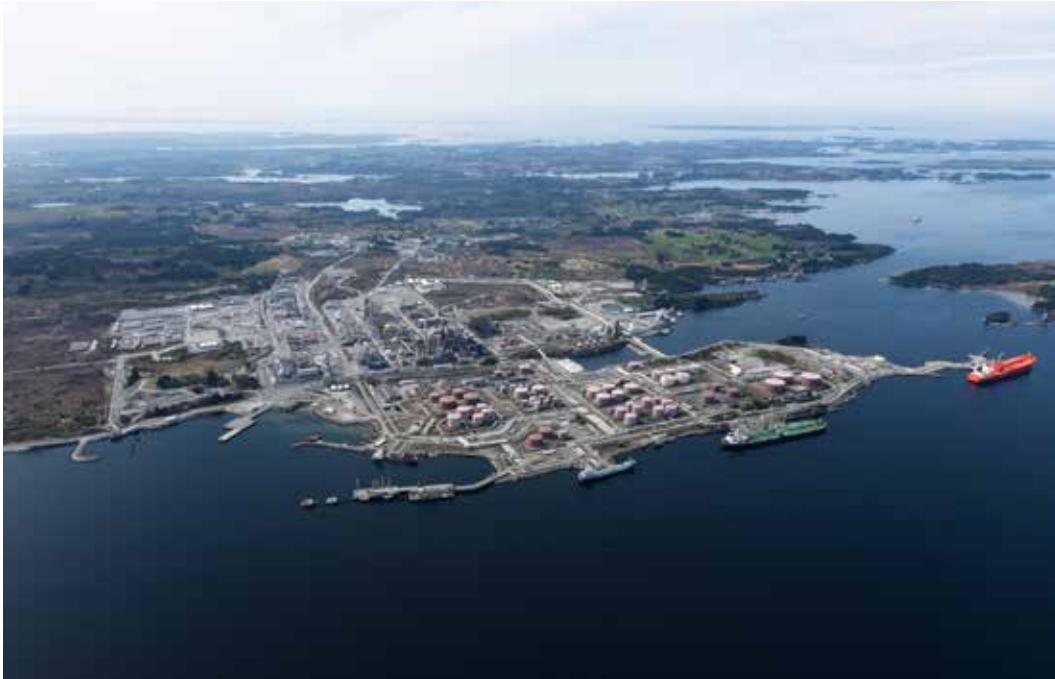
Kutt i bevilgninger til vedlikehold og manglende oppfølging av regelverksavvik medvirket til den alvorlige hendelsen på Mongstad landanlegg i 2016. Kilde: Helge Hansen, Equinor
